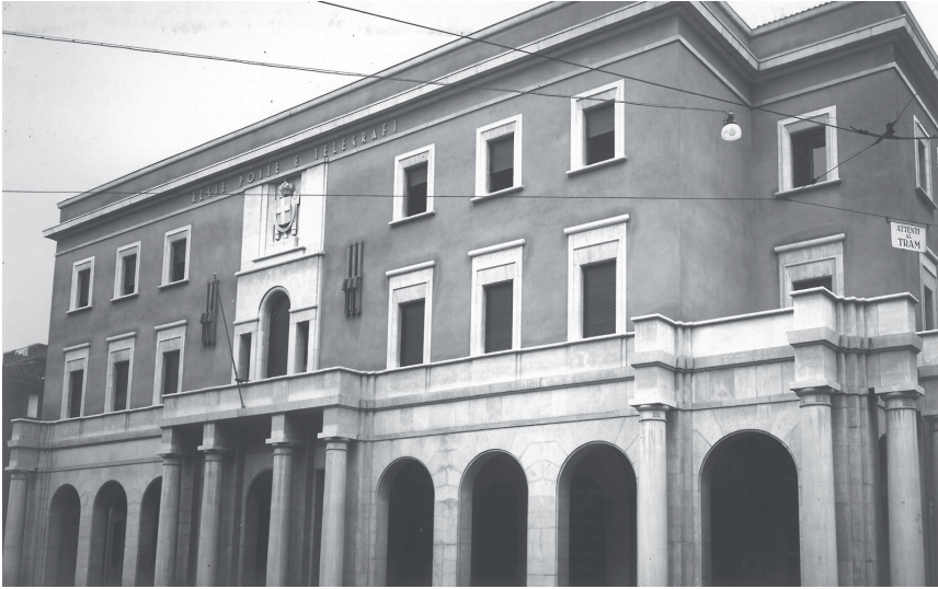
La facciata di Palazzo Poste a Vicenza. Classica architettura del Ventennio
